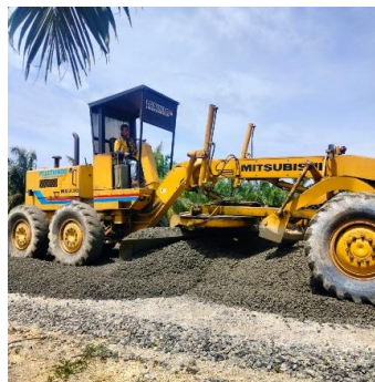
Gambar 2. Motor Grader yang Digunakan pada Pekerjaan LPA
