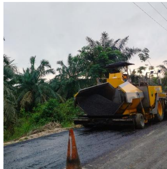
Gambar 3. Asphalt Finisher pada Pekerjaan AC-WC
